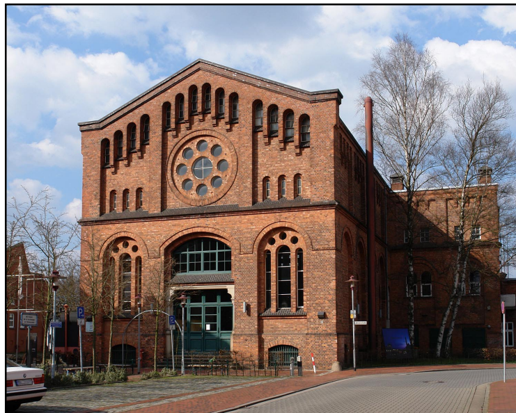
Nordwolle in Delmenhorst. Ehemaliges Turbinenhaus, die „Kathedrale der Arbeit“. Erbaut 1902, Architekt Henrich Deetjen
